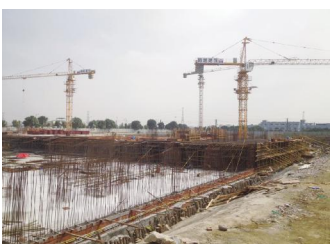
东莞沙田项目塔吊在不停地运转
