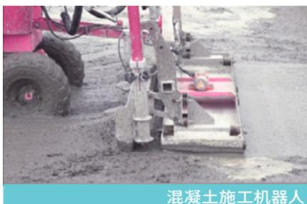
混凝土施工机器人
